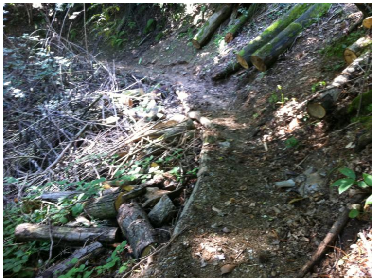
Sistemazione con pali di castagno a rinforzo di cigli e scalini, scavo a mano e taglio alberi caduti sul tracciato.
