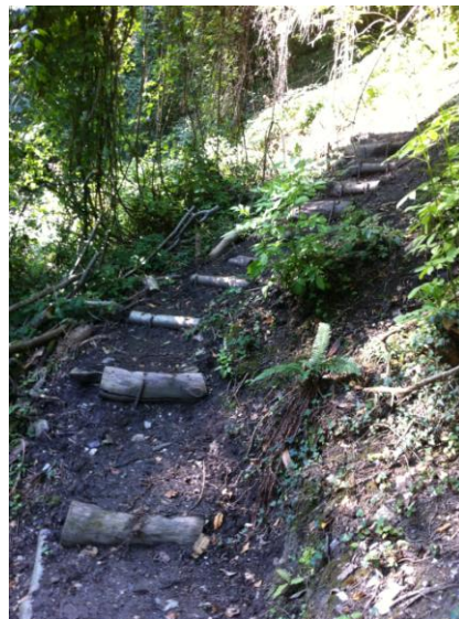
Sistemazione con pali di castagno a rinforzo di cigli e scalini, scavo a mano e taglio alberi caduti sul tracciato.
