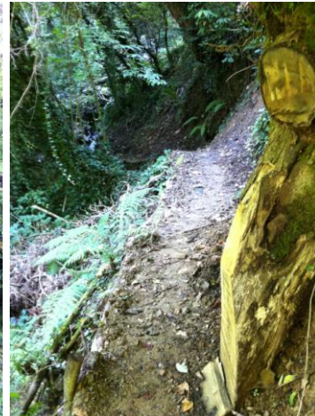
Sistemazione con pali di castagno a rinforzo di cigli e scalini, scavo a mano e taglio alberi caduti sul tracciato.
