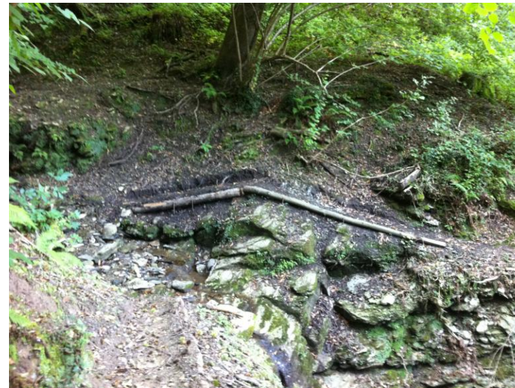
Sistemazione con pali di castagno a rinforzo di cigli e scalini, scavo a mano e taglio alberi caduti sul tracciato.
