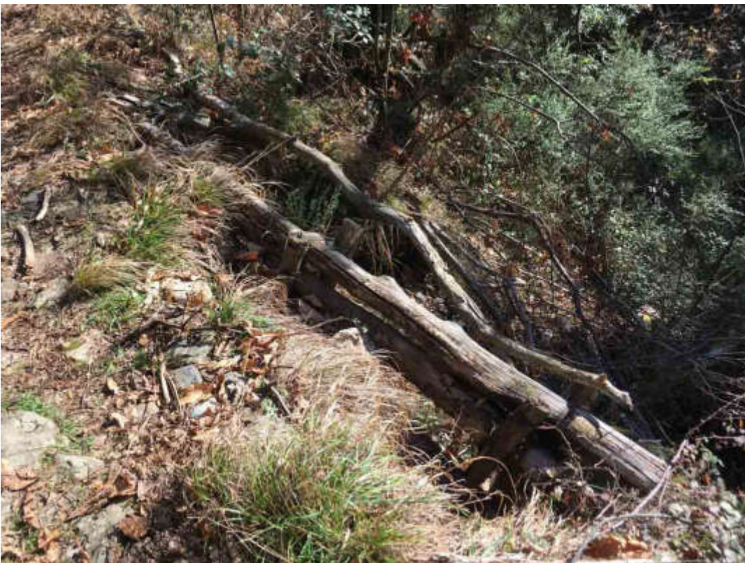
Foto 2 Rifacimento palizzata a tre pali
