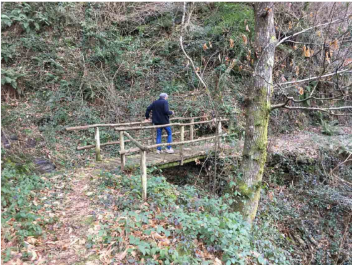
Foto 4 Rifacimento passerella pedonale
