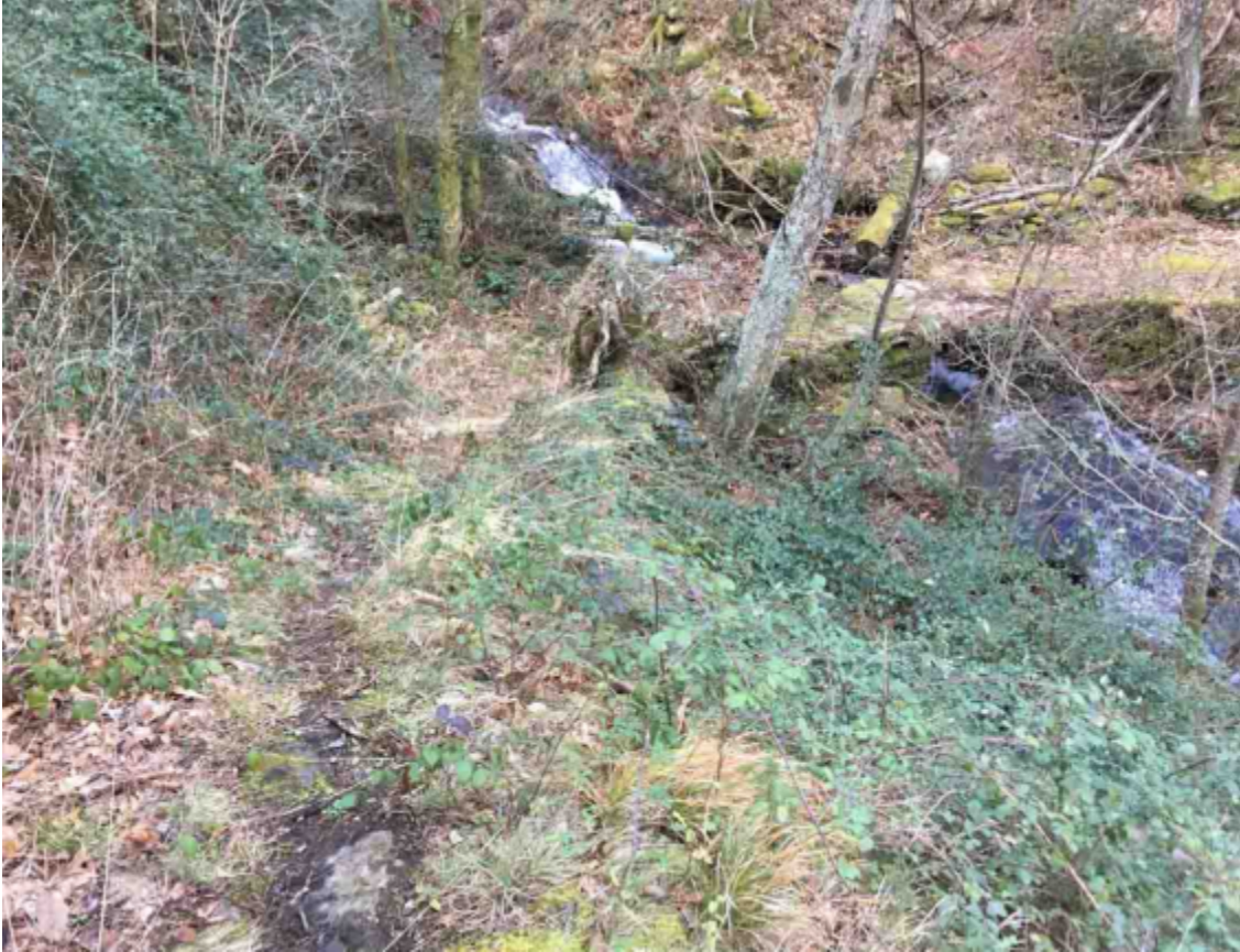
Foto 5 palizzata a due pali
