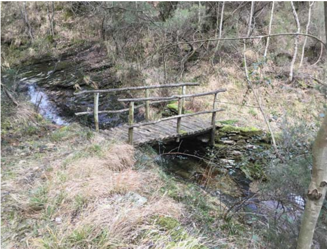
Foto 6 Rifacimento passerella pedonale
