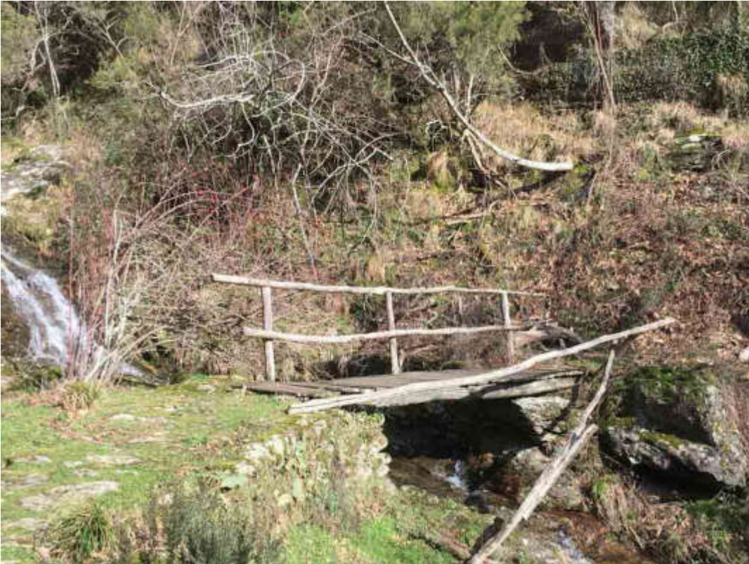
Foto 1 Rifacimento passerella pedonale
