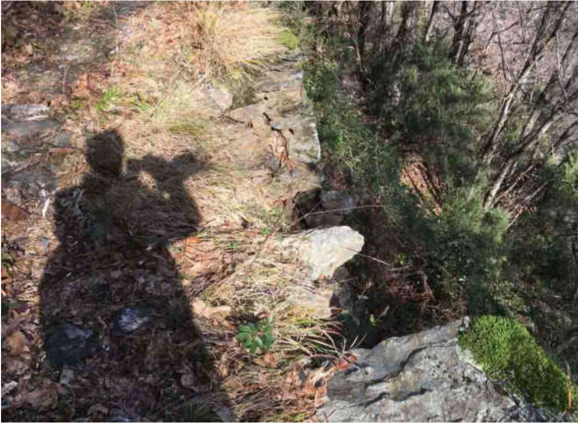
Foto 3 ripristino di muri a secco
