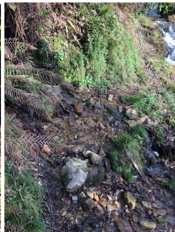
Foto 4, 5 e 6 rimozione del materiale terroso e alberi franati con ripristino sezione sentiero per circa dieci metri.
