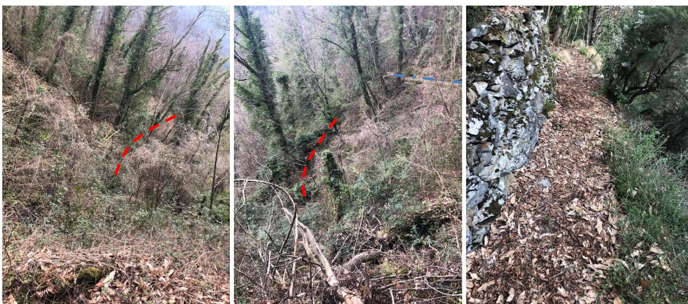
La vicinale di Malpasso è caduta in disuso dopo l'evento alluvionale del 1996, interrotto da una frana alla partenza da Cardoso (foto1), causata dall'erosione al piede della scarpata da parte del Torrente Capriola. La traccia del sentiero è visibile, ma alcuni tratti sono interrotti da movimenti franosi e cadute di alberi che rendono necessaria l'apertura ex novo per alcune decine di metri di lunghezza della sezione mediante taglio di alberi e scavo a mano per realizzare una larghezza di 60 cm.
