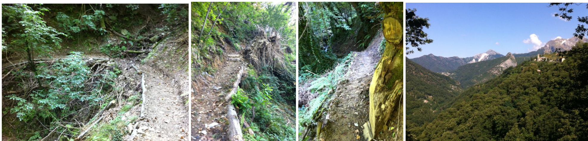
Sistemazione con pali di castagno a rinforzo di cigli e scalini, scavo a mano e taglio alberi caduti sul tracciato.
