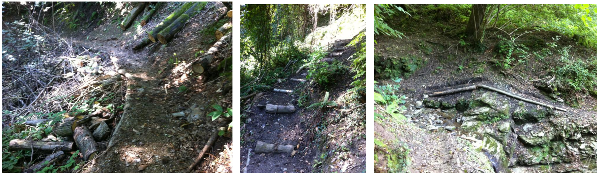
Sistemazione con pali di castagno a rinforzo di cigli e scalini, scavo a mano e taglio alberi caduti sul tracciato.
